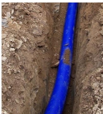
■ Installation en cours
