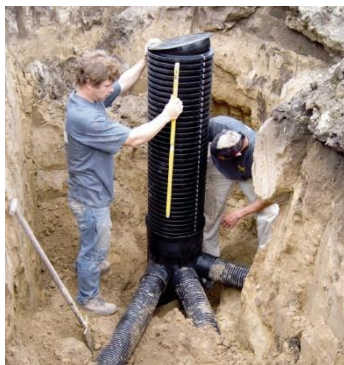
■ Pose du regard
