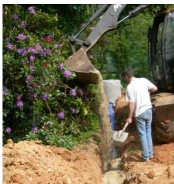
■ Remblai à la pelle mécanique
